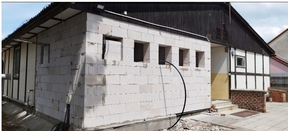
Pohled na nové prostory WC v budově tesko
