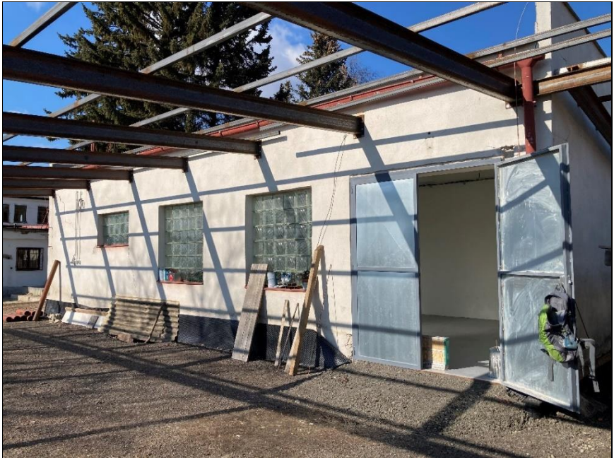
Ocelová konstrukce nového přístřešku
